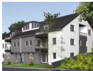
COLMAR-BERG RESIDENCE CAMUS Appartements à partir de 295 336 €
